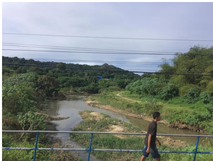
Figura 3: Ponte na localidade do Banheiro do Soldado
