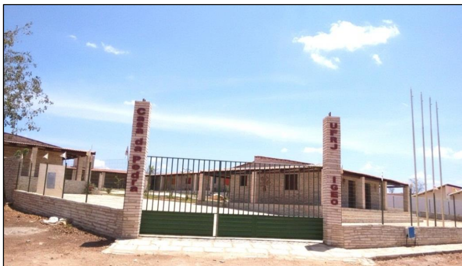
Figura 3 - Casa de Pedra da UFRJ em Santana do Cariri
