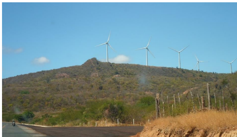
Figura 3 - Aerogeradores próximo a BR – 316, acesso a Marcolândia –PI.
