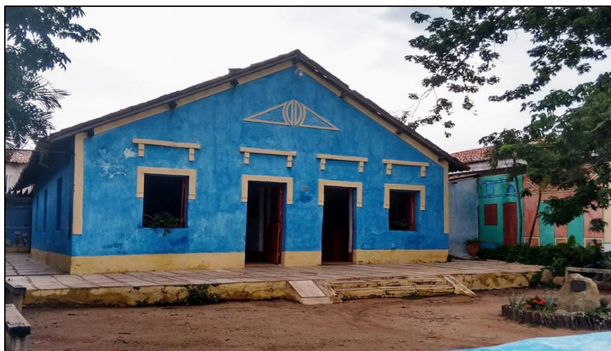
Figura 1 - Fundação Casa Grande em Nova Olinda – CE
