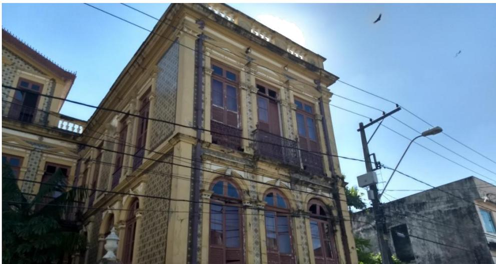
**Figura 3: Janela do Palacete Pinho. Nesta outra foto além do crescimento do mato nas paredes do palacete, pode-se verificar também vidros quebrados, a pintura descascando e rachaduras nas paredes do palacete. Outrora símbolo de suntuosidade, hoje reflexo do abandono. Fonte: Ellen Alves, 2017.**
