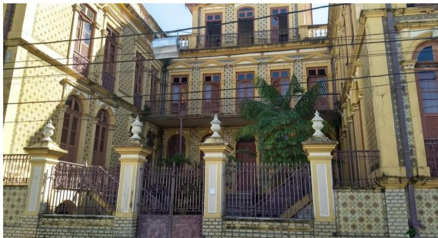
**Figura 1: Fachada do Palacete Pinho. Já se pode observar como as ações do tempo são desfavoráveis ao patrimônio, através das janelas e vidro quebrados, rachaduras nas paredes, crescimento do mato. Fonte: Ellen Alves, 2017.**
