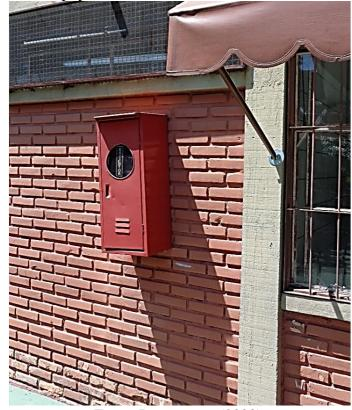
Figura 13 – Equipamento de combate a incêndio sem sinalização.
