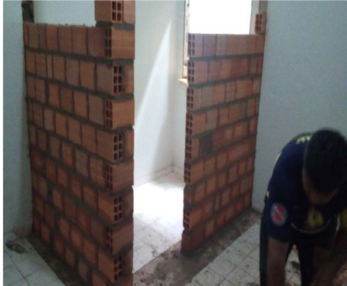
Figura 4 – Alvenaria com argamassa convencional.
