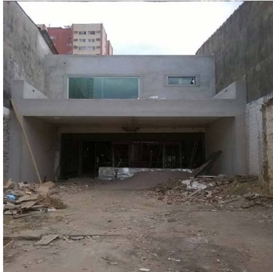
Figura 3 – Residência familiar de 2 pavimentos.
