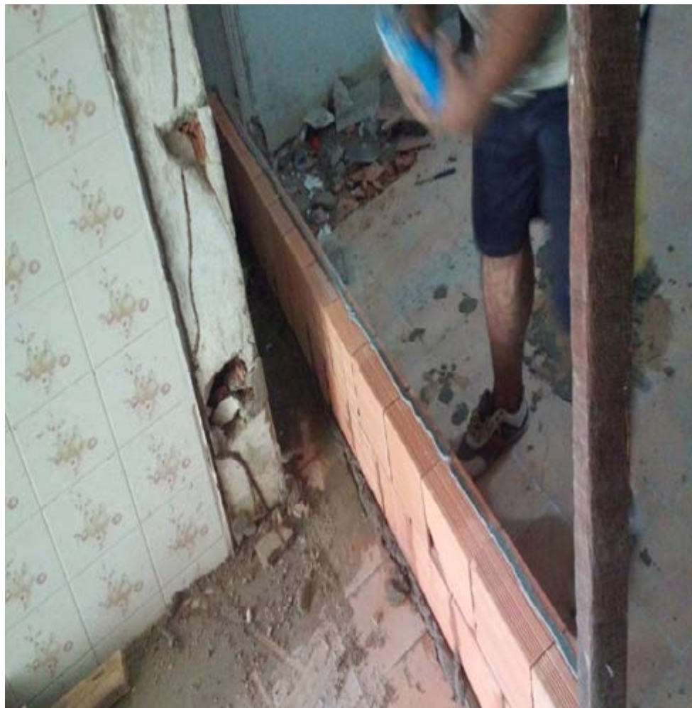
Figura 5 – Alvenaria com argamassa polimérica Biomassa.
