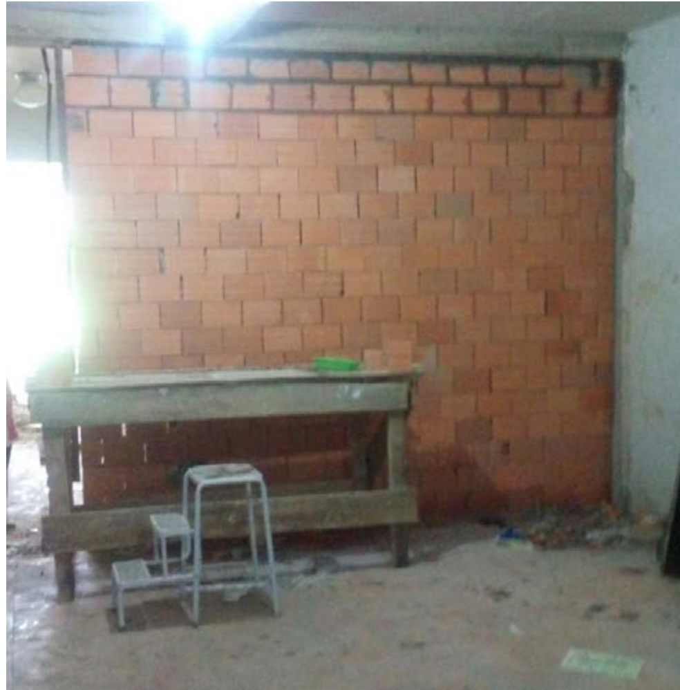
Figura 6 – Parede com argamassa polimérica.
