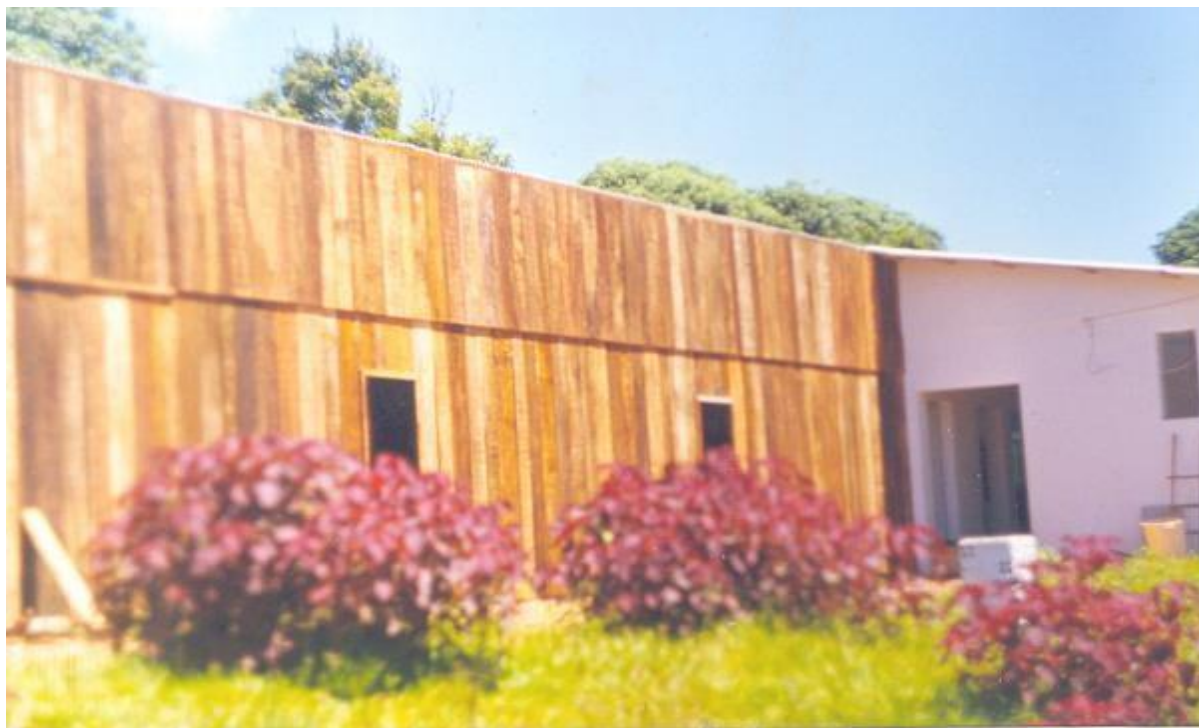
Figura 2 - Salas já construídas, 1999.
