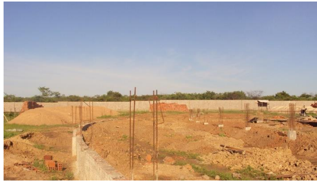
Imagem de Etapas da Construção do Prédio Administrativo. Construtora Pilar Serviços Ltda. 09 de janeiro de 2012
