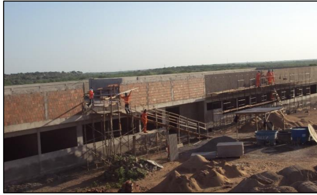
Imagem de Etapas da Construção do Bloco de Salas de Professores. Empresa Antártida Refrigeração, Serviços Técnicos e Construção Ltda. Início da obra 04 de julho de 2011
