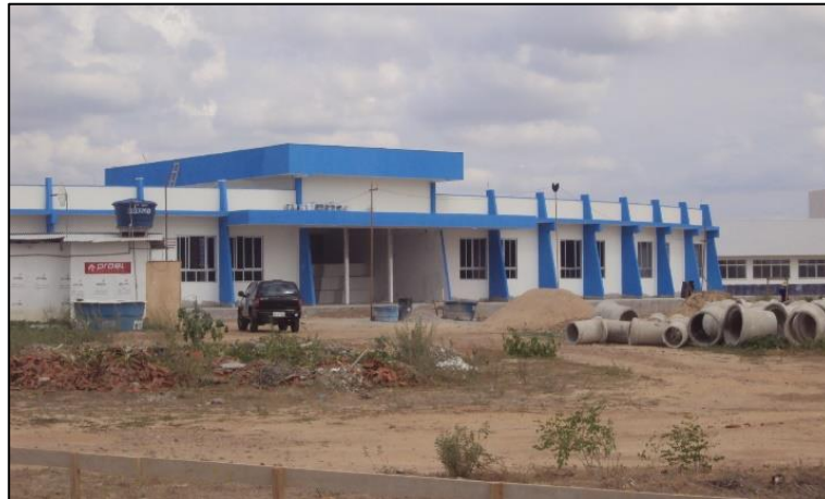
Imagem de Etapas da Construção do Prédio Administrativo, Construtora Proel Projeto de Engenharia e Construções Ltda. OS, 10 de janeiro de 2011
