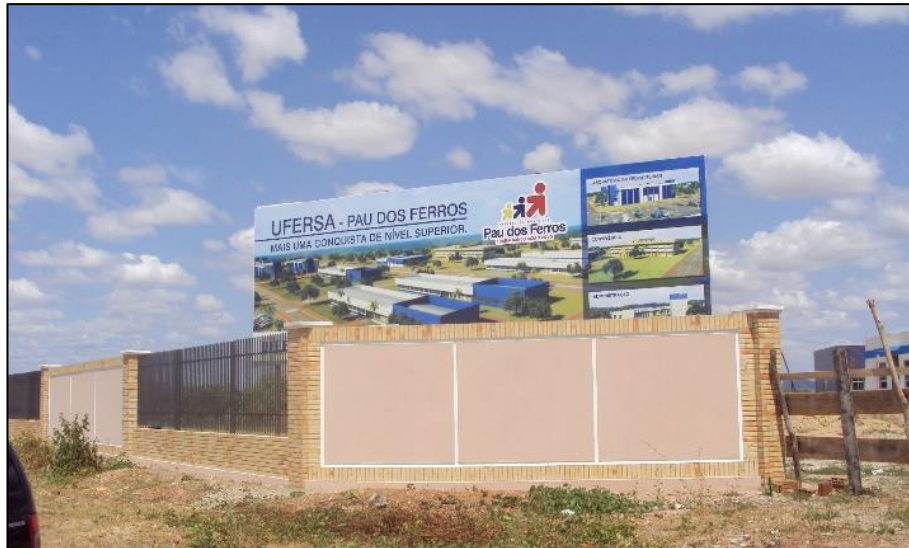
Imagem de Etapas da Construção: Muro de Contorno, Frontal e Guarita, Construtora Assú e Empreendimento Ltda. OS, 29 de novembro de 2010
