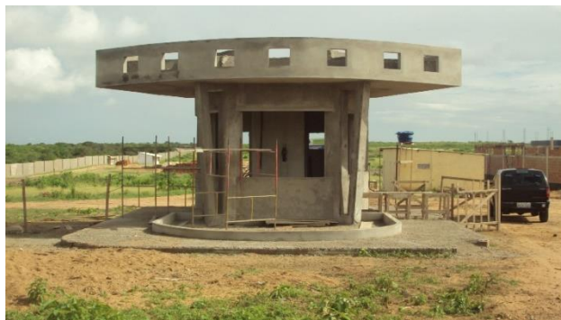
Imagem de Etapas da Construção do Muro e Guarita. Empresa Pilar Serviços Ltda. Início da obra 15 de agosto de 2011
