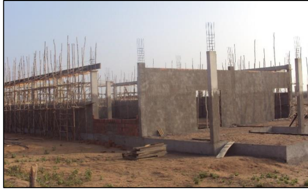
Imagem de Etapas da Construção do Prédio do Almoarifado e Patrimônio. Construtora Antártida Refrigeração, Serviços Técnicos e Construção Ltda. Início da obra 04 de julho de 2011
