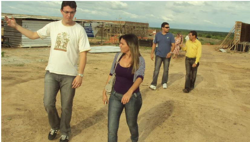
Imagem de Visita de professores do Campus de Caraúbas durante as construções das estruturas física do campus, 2011
