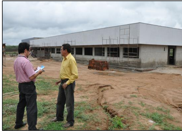
Imagem de Etapas da Construção do Bloco de Salas de Aulas. Empresa A & C Construções Ltda. Início da obra 04 de julho de 2011
