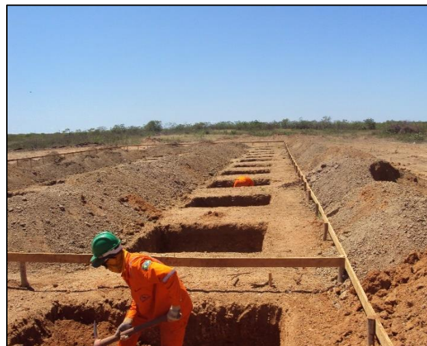
Imagem de Etapas da Construção do Bloco de Salas de Professores. Empresa Antártida Refrigeração, Serviços Técnicos e Construção Ltda. Início da obra 04 de julho de 2011
