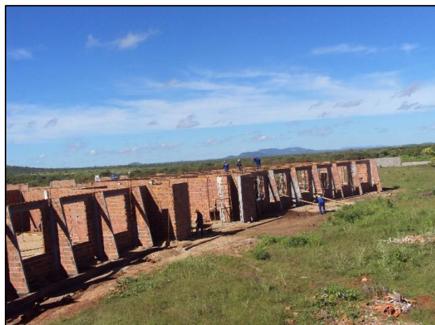
Imagem de Etapas da Construção do Prédio Administrativo, Construtora Proel Projeto de Engenharia e Construções Ltda. OS, 10 de janeiro de 2011
