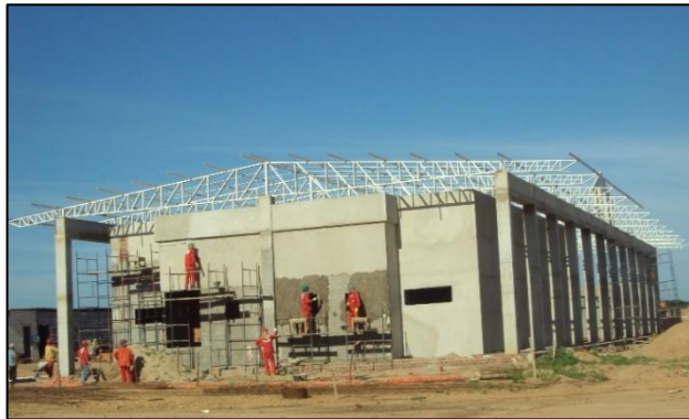
Imagem de Etapas da Construção do Centro de Convivência e Auditório. Empresa A & C Construções Ltda, Início da obra 22 de agosto de 2011
