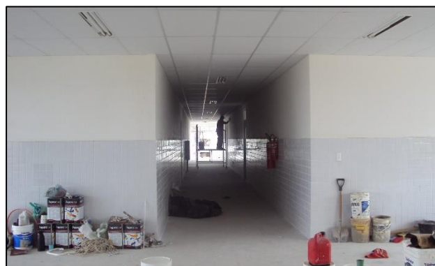
Imagem de Etapas do Início da Construção do Bloco de Sala de Aula. Construtora A & C Construtora Ltda. OS, 20 de dezembro de 2010
