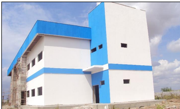
Imagem de Etapas da Construção do Bloco de Laboratórios. Construtora Proel Projeto de Engenharia e Construções Ltda. OS, 10 de janeiro de 2011
