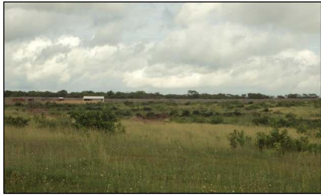
Imagem de Etapas da Construção do Muro e Guarita. Empresa Pilar Serviços Ltda. Início da obra 15 de agosto de 2011
