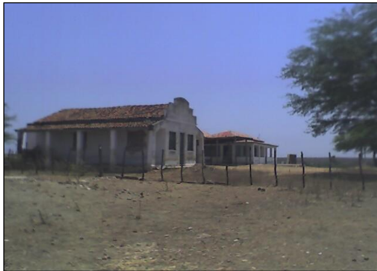
Vista de Residências sede e de produtor, Fazenda do Formento Agrícola, local das instalações do futuro prédio administrativo e reservatórios d'água
