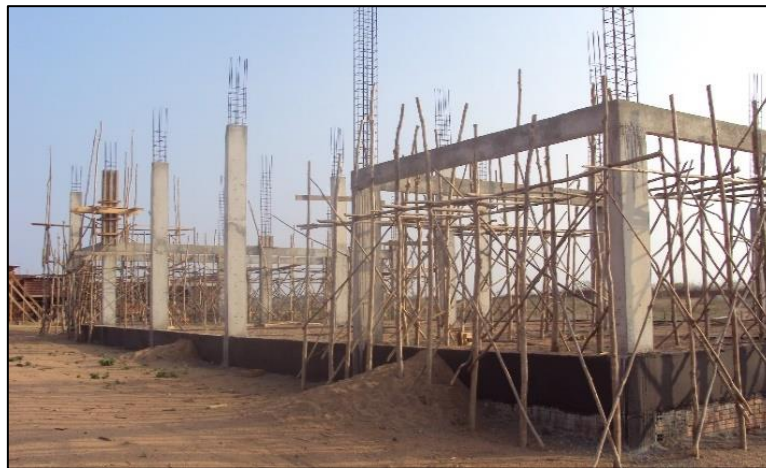
Imagem de Etapas da Construção do Prédio do Almojarifado e Patrimônio. Construtora Antártida Refrigeração, Serviços Técnicos e Construção Ltda. Início da obra 04 de julho de 2011
