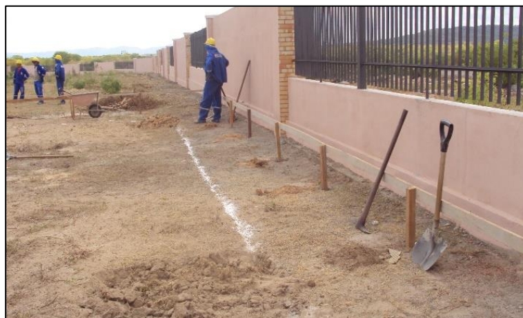
Imagem de Etapas da Construção: Muro de Contorno, Frontal e Guarita, Construtora Assú e Empreendimento Ltda. OS, 29 de novembro de 2010
