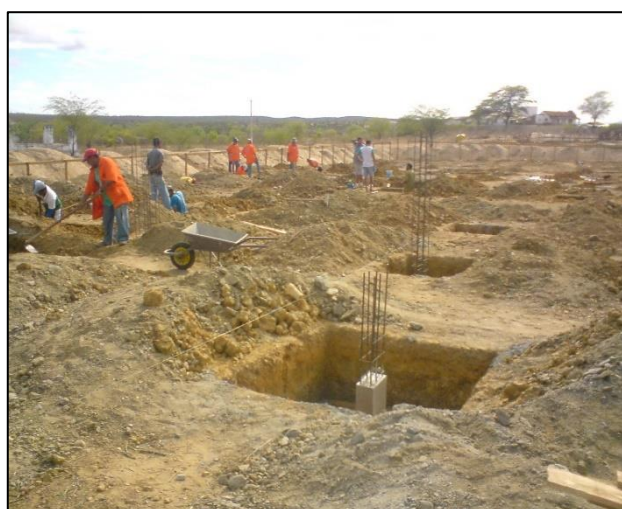
Imagem de etapas da construção da Biblioteca. Construtora A & C Construções Ltda.
