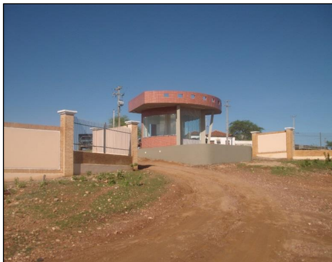
Imagem do muro de frontal e guarita do campus Angicos. Construtora Andrade Construções e Empreendimentos Ltda. Início da obra 29 de dezembro de 2008
