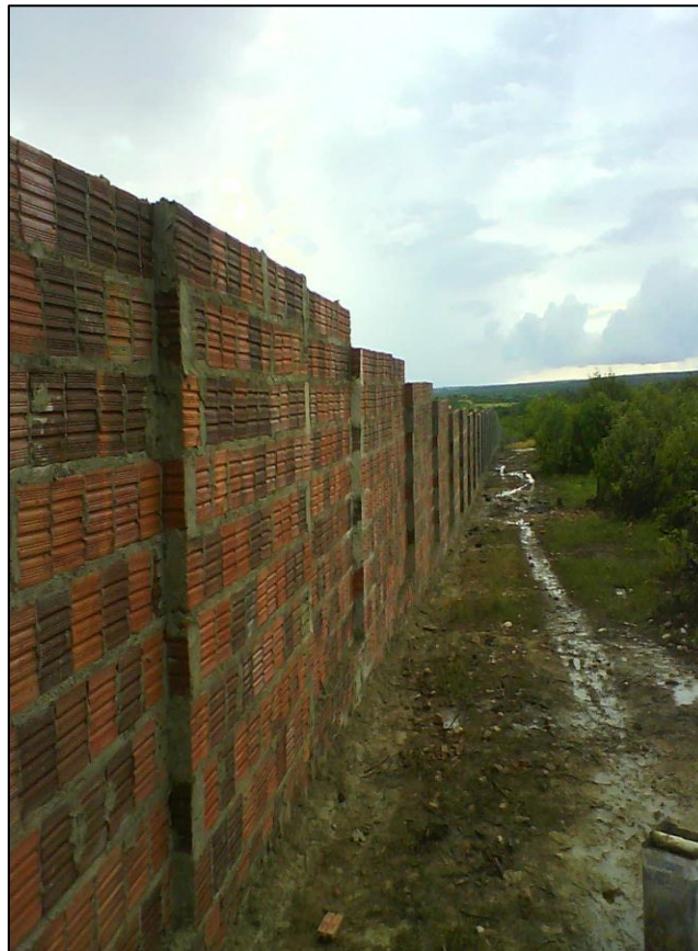
Imagem do muro de contorno do campus Angicos. Construtora Andrade Construções e Empreendimentos Ltda. Início da obra 29 de dezembro de 2008
