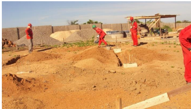
Imagem de Etapas da Construção do Reservatórios e Instalações de Redes Hidros Sanitárias. Empresa A & C Construções Ltda. 07 de novembro de 2011
