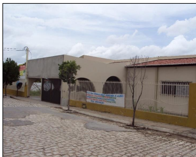
Imagem das Estruturas Provisórias do Campus da Ufersa Caraúbas, na Escola Estadual Lourenço Gurgel
