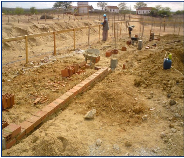
Imagem de Etapas da Construção do Bloco de Sala de Aula.
