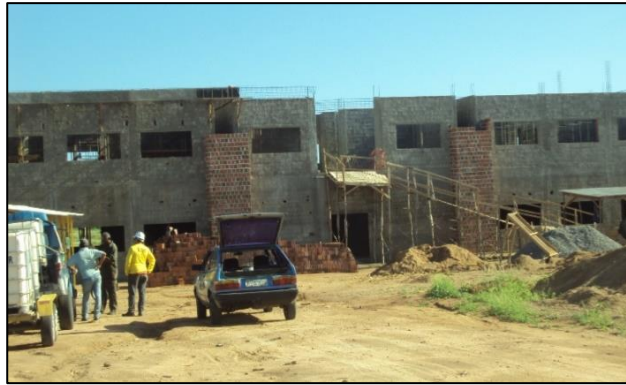
Imagem de Etapas da Construção do Bloco de Laboratórios. Empresa Pilar Serviços Ltda. Início da obra 04 de julho de 2011
