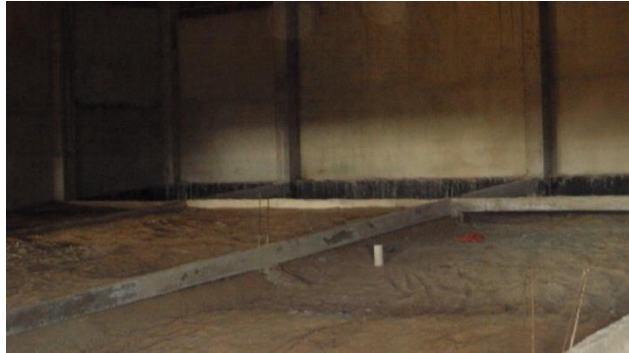
Imagem de Etapas da Construção do Bloco de Salas de Aulas. Empresa A & C Construções Ltda. Início da obra 04 de julho de 2011
