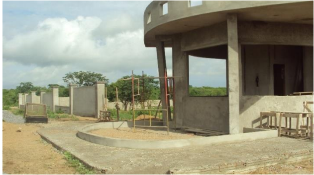
Imagem de Etapas da Construção do Muro e Guarita. Empresa Pilar Serviços Ltda. Início da obra 15 de agosto de 2011
