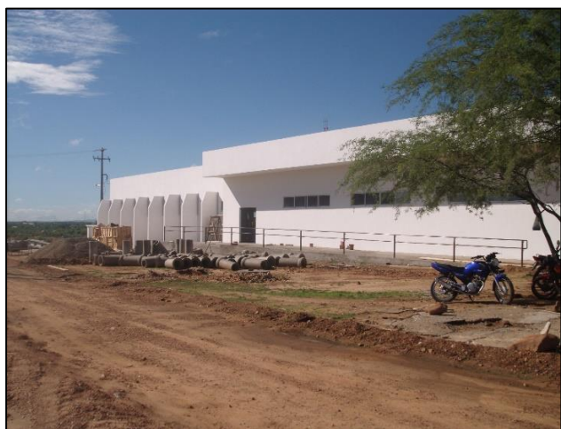
Imagem de etapas da construção da Biblioteca. Construtora A & C Construções Ltda. Início da obra 29 de dezembro de 2008
