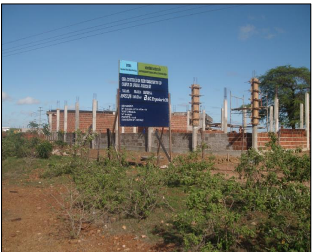
Imagem de etapas da construção do Prédio Administrativo do Campus da Ufersa Angicos. Construtora A & C Construções Ltda. Início da obra 04 de janeiro de 2010
