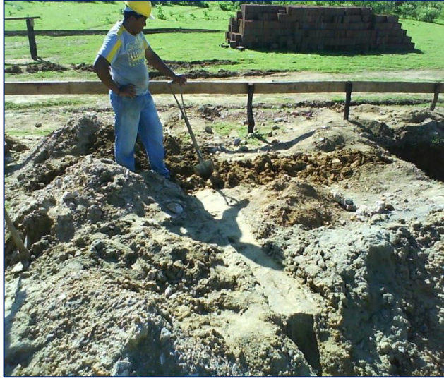
Imagem de Etapas da Construção do Bloco de Laboratórios. Construtora Projetus Engenharia Ltda., Início da obra 29 de dezembro de 2008
