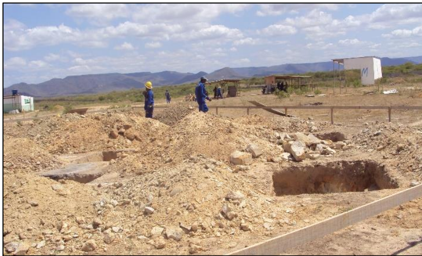
Imagem de Etapas da Construção dos Reservatórios Inferior e Superior, Construtora Proel Projeto de Engenharia e Construções Ltda. OS, 05 de dezembro de 2011
