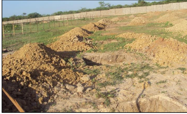
Imagem de Etapas da Construção do Prédio Administrativo. Construtora Pilar Serviços Ltda. 09 de janeiro de 2012
