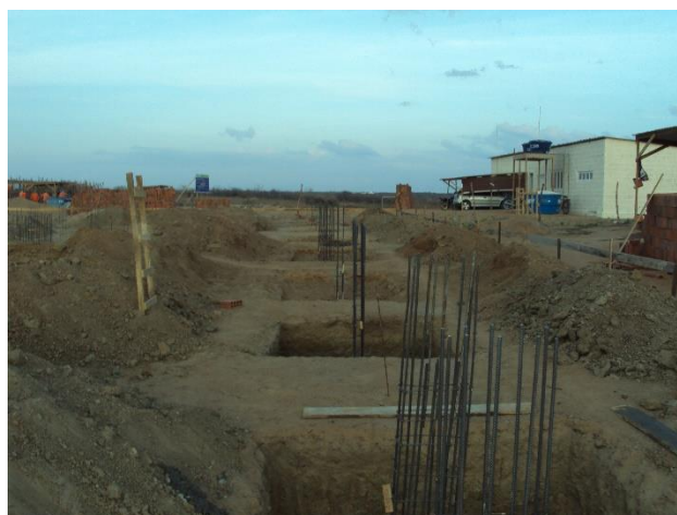
Imagem de Etapas da Construção do Bloco de Laboratórios. Empresa Pilar Serviços Ltda. Início da obra 04 de julho de 2011
