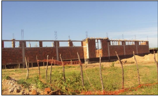
Imagem de Etapas da Construção do Prédio da Biblioteca. Empresa Antártida Refrigeração, Serviços Técnicos e Construção Ltda. Início da obra 08 de setembro 2011
