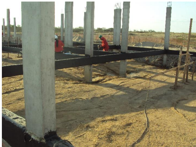
Imagem de Etapas da Construção do Bloco de Salas de Aulas. Empresa A & C Construções Ltda. Início da obra 04 de julho de 2011
