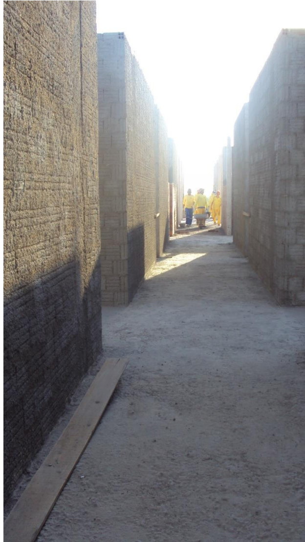
Imagem de Etapas da Construção do Bloco de Laboratórios. Empresa Pilar Serviços Ltda. Início da obra 04 de julho de 2011
