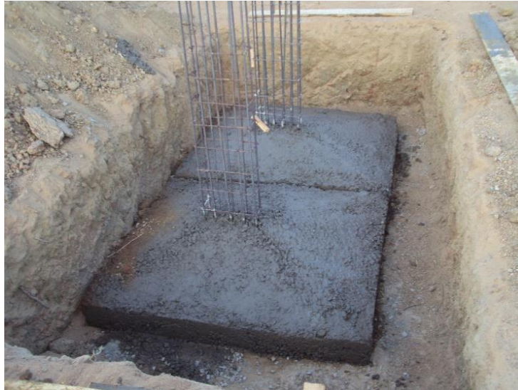
Imagem de Etapas da Construção do Bloco de Laboratórios. Empresa Pilar Serviços Ltda. Início da obra 04 de julho de 2011
