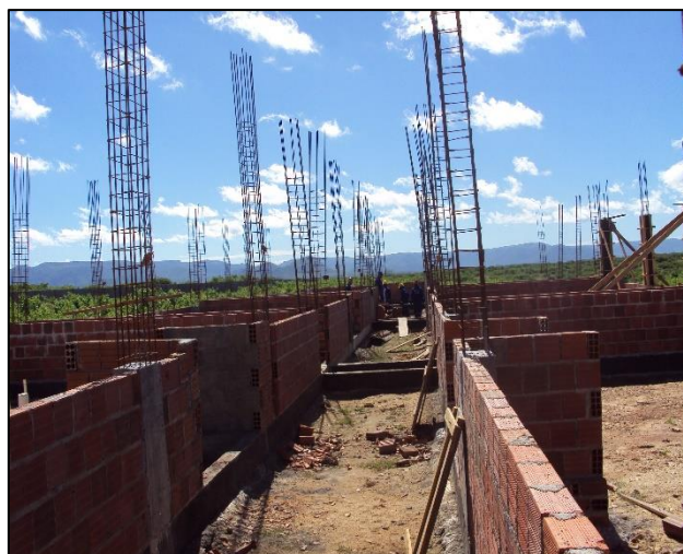
Imagem de Etapas da Construção do Bloco de Laboratórios. Construtora Proel Projeto de Engenharia e Construções Ltda. OS, 10 de janeiro de 2011
