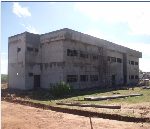
Imagem de Etapas da Construção do Bloco de Laboratórios.
