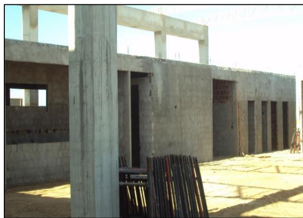
Imagem de Etapas da Construção do Centro de Convivência e Auditório. Empresa A & C Construções Ltda, Início da obra 22 de agosto de 2011
