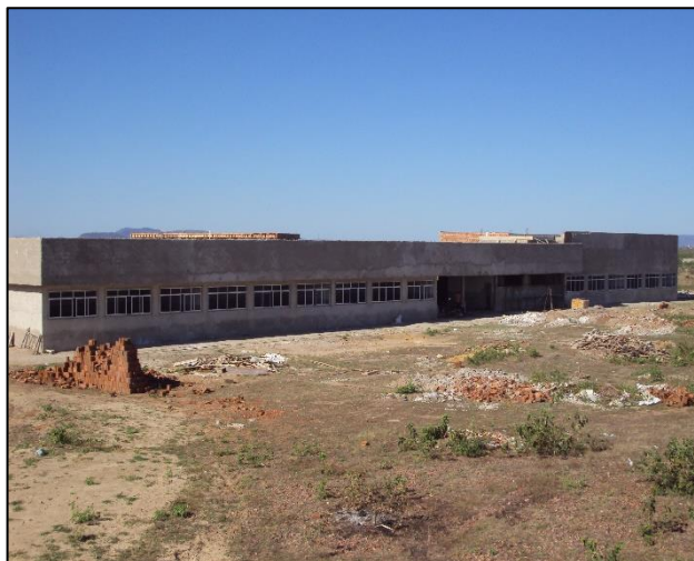
Imagem de Etapas do Início da Construção do Bloco de Sala de Aula. Construtora A & C Construtora Ltda. OS, 20 de dezembro de 2010
