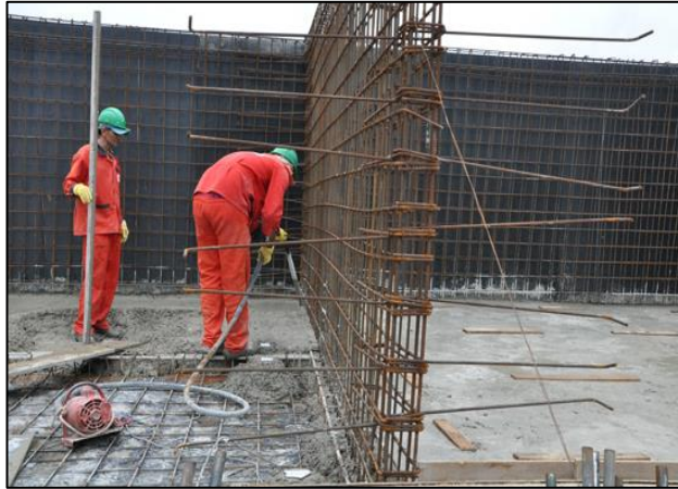
Imagem de Etapas da Construção do Reservatórios e Instalações de Redes Hidros Sanitárias. Empresa A & C Construções Ltda. 07 de novembro de 2011
