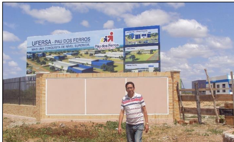
Imagem de Etapas da Construção: Muro de Contorno, Frontal e Guarita, Construtora Assú e Empreendimento Ltda. OS, 29 de novembro de 2010
