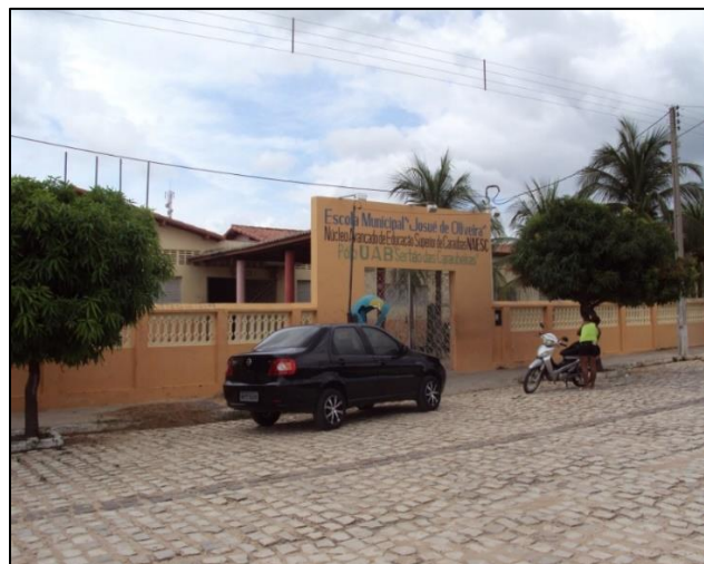
Imagem das Estruturas Provisórias do Campus da Ufersa Caraúbas, no Escola Municipal Josué de Oliveira
