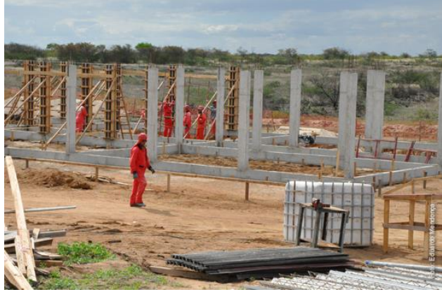
Imagem de Etapas da Construção do Bloco de Salas de Aulas. Empresa A & C Construções Ltda. Início da obra 04 de julho de 2011
