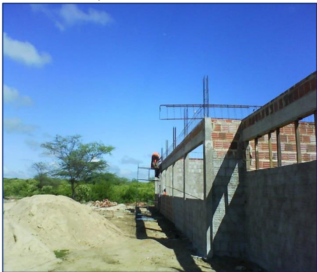
Imagem de Etapas da Construção do Bloco de Sala de Aula. Construtora N S Construções Ltda. Início da obra 29 de dezembro de 2008
