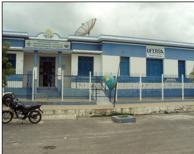
Imagem das Estruturas Provisórias do Campus da Ufersa Caraúbas, no Colégio Estadual Antônio Carlos
