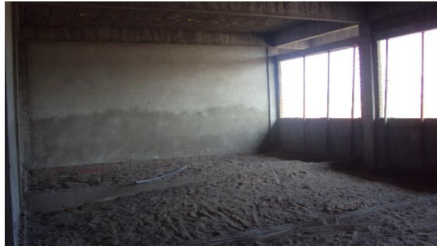
Imagem de Etapas da Construção do Bloco de Salas de Aulas. Empresa A & C Construções Ltda. Início da obra 04 de julho de 2011
