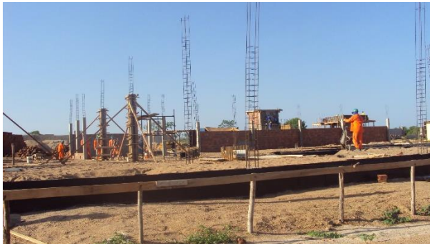
Imagem de Etapas da Construção do Prédio da Biblioteca. Empresa Antártida Refrigeração, Serviços Técnicos e Construção Ltda. Início da obra 08 de setembro 2011
