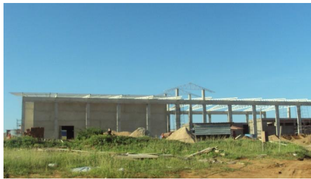
Imagem de Etapas da Construção do Centro de Convivência e Auditório. Empresa A & C Construções Ltda, Início da obra 22 de agosto de 2011
