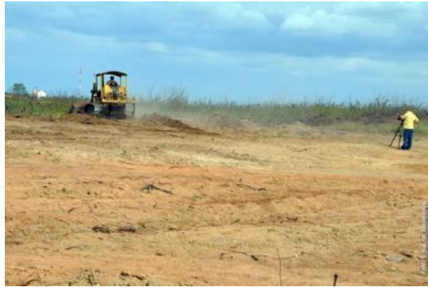
Início da Construção do Campus de Caraúbas, Desmatamento do Terreno, Executado pela prefeitura municipal, junho de 2011
