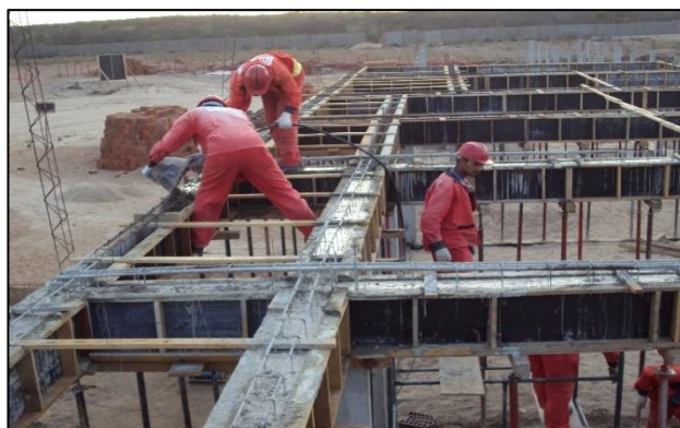
Imagem de Etapas da Construção do Bloco de Salas de Professores. Empresa Antártida Refrigeração, Serviços Técnicos e Construção Ltda. Início da obra 04 de julho de 2011
