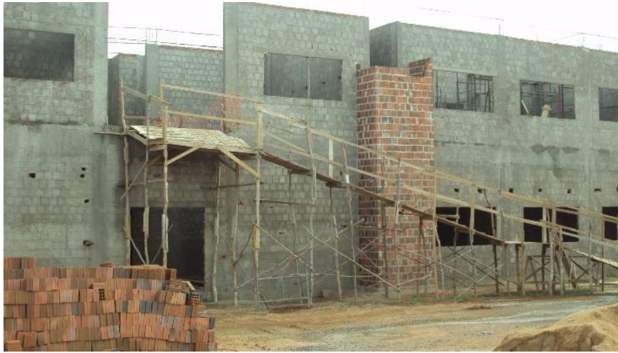
Imagem de Etapas da Construção do Bloco de Laboratórios. Empresa Pilar Serviços Ltda. Início da obra 04 de julho de 2011
