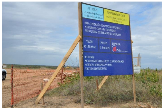
Imagem de Etapas da Construção do Centro de Convivência e Auditório. Empresa A & C Construções Ltda, Início da obra 22 de agosto de 2011
