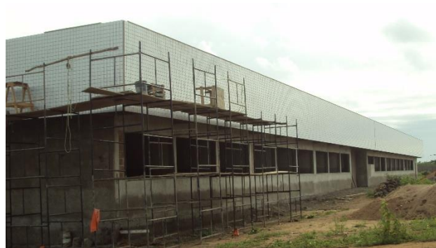
Imagem de Etapas da Construção do Bloco de Salas de Professores. Empresa Antártida Refrigeração, Serviços Técnicos e Construção Ltda. Início da obra 04 de julho de 2011
