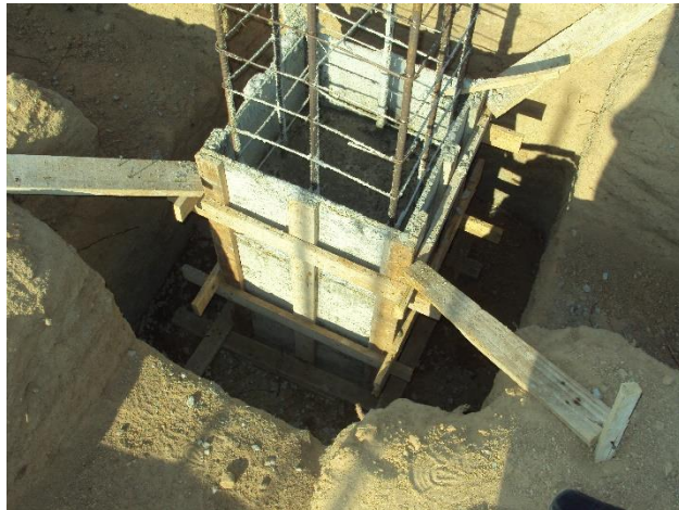
Imagem de Etapas da Construção do Bloco de Salas de Professores. Empresa Antártida Refrigeração, Serviços Técnicos e Construção Ltda. Início da obra 04 de julho de 2011
