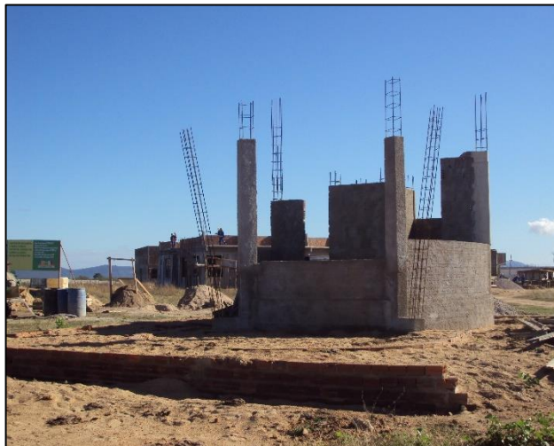
Imagem de Etapas da Construção: Muro de Contorno, Frontal e Guarita, Construtora Assú e Empreendimento Ltda. OS, 29 de novembro de 2010
