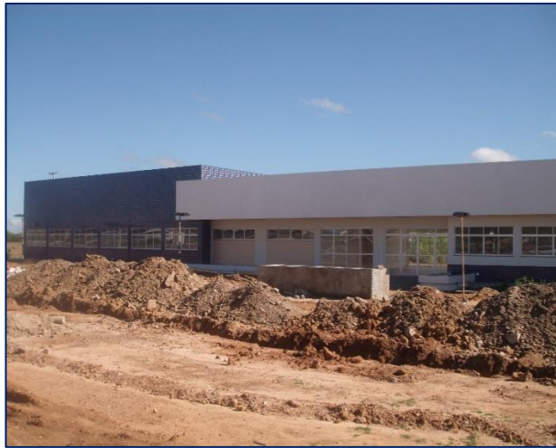
Imagem de Etapas da Construção do Bloco de Sala de Aula. Construtora N S Construções Ltda. Início da obra 29 de dezembro de 2008
