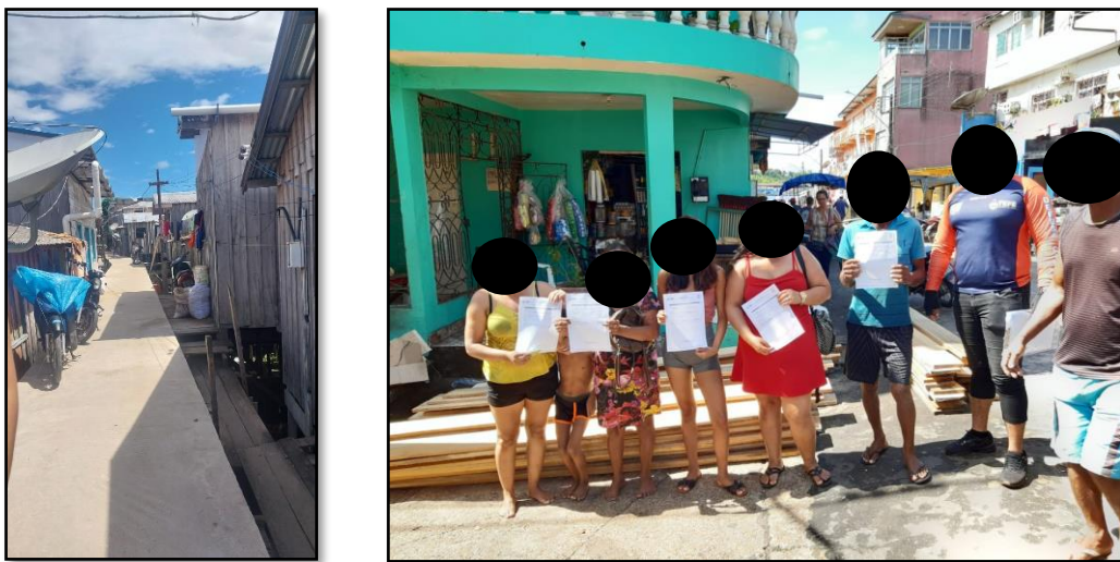
Figuras 13 e 14 - Intervenções da prefeitura municipal de Tefé na rua Otaviano de Melo: construção de ponte de concreto e cadastramento para o recebimento de madeira
