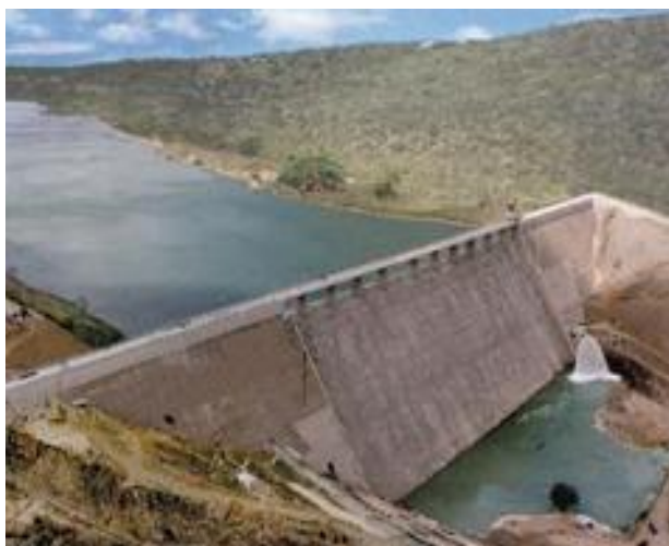
Figura 01. Localização da Barragem de Acauã, Itatuba – PB.
